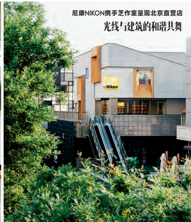
尼康携手芝作室以一场视觉与空间的革新呈现北京尼康直营店。设计从自然界中汲取灵感，与工业设计元素相结合，创造出独特的空间语言。团队秉承环保理念，再利用原有幕墙结构，通过对主次结构的梳理和室内外功能的整合，为外墙设计了一件新“外衣”，并采用不同特性的材料进行搭配，创造出丰富的立面层次。竹钢的纹理为窗洞的框架增添了一种向外延伸的动感，而不同大小的窗洞如同相机的取景器，捕捉着周围环境中有趣的瞬间。光线与建筑的和谐共舞，传递了“光是摄影灵魂”的主题。在日光下，建筑的体量与不同透光度的开口记录着一天中不同时刻光线的微妙变化；夜幕降临，外立面的不同元素形成了动态互补。光影的交错不仅为店铺空间带来诗意，也提供了丰富多变的场景。
