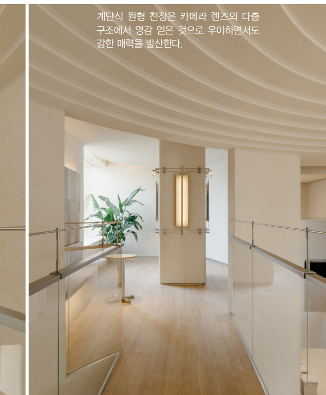
워크숍 공중 보행로 난간은 두 층에서 유람하는 고객 간 시야를 고려해 목재와 알루미늄 구조에 폴리카보네이트 패널로 제작했다.
